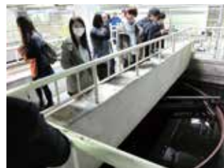
汚水処理場内
