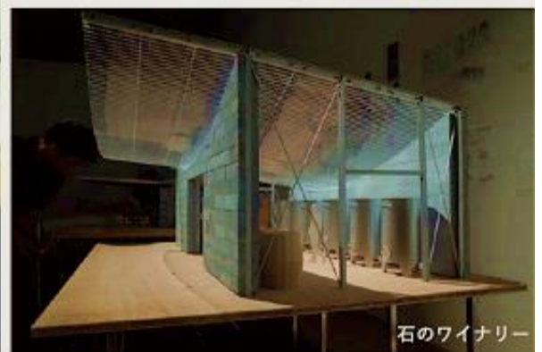
石のワイナリー【逆アーチによる自碇式吊り屋根構造】
