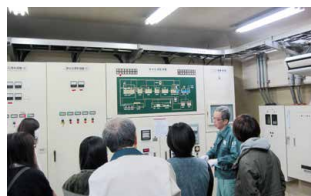
排水処理監視盤の説明
