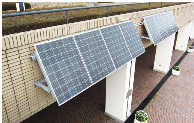
1号館(総合棟)ペDESTロリアンデッキ前
