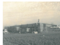
建設中の小金井校舎
