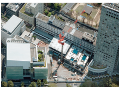
55・58年館建替工事が進行中の市ヶ谷キャンパス
