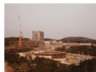
建設中の多摩校舎
