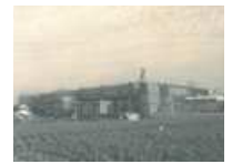
建設中の小金井校舎
