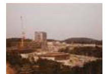
建設中の多摩校舎
