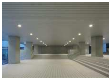
富士見坂校舎屋外ピロティ化改修
