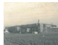
建設中の小金井校舎
