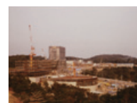
建設中の多摩校舎
