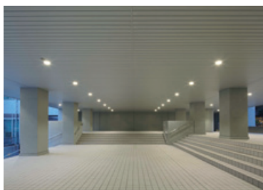
富士見坂校舎屋外ピロティ化改修
