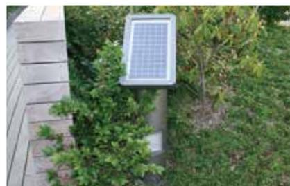
屋上庭園には、太陽光発電パネル付ガーデンライトを設置し、照明設備に自然エネルギーを利用しています。
