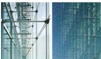
太陽高度の低い西側に面する外皮のガラスに日射をカットするフィルムを使用し夏の空調負荷を軽減し、また冬季はダブルスキン内にたまった熱を暖房に利用します。
