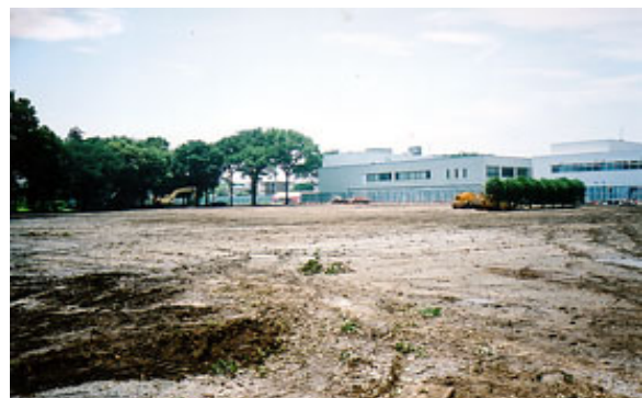
前建物の解体工事が終了し、更地状態の研究所建設予定地とプレイグラウンド予定地。樹林をそのまま利用し武蔵野の面影を残した。
