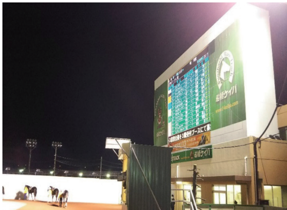
写真 2-1 改修工事中の船橋競馬 (2020年12月：筆者撮影)
