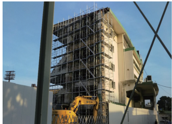
写真 2-2 改修工事中の川口オート (2020年8月：筆者撮影)
