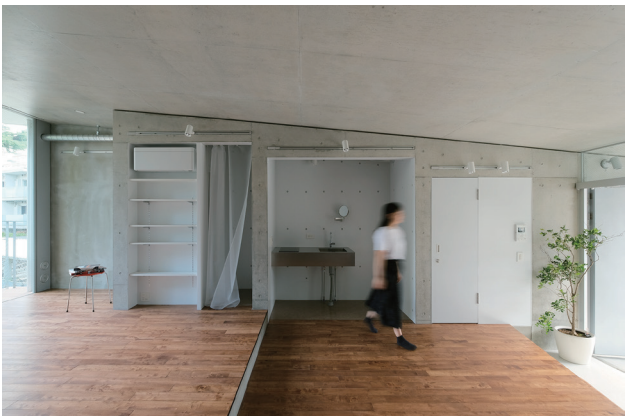
3B室：玄関（西側）からテラス（東側）に斜めスラブがかかり、床はスキップ状の構成。
