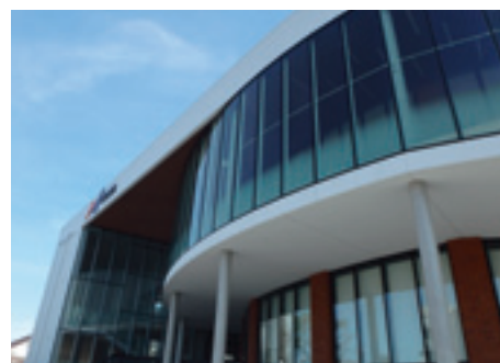
木月総合文化棟(講堂・図書館・食堂エリア)
