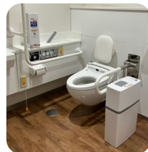
だれでもトイレへの設置
