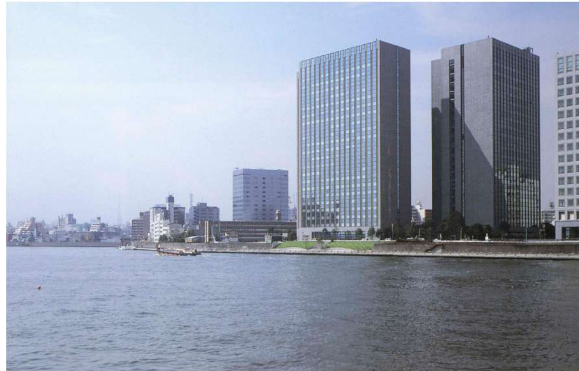
東側全景 手前は隅田川
