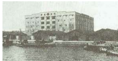
住友倉庫 (越前堀倉庫) 1921年竣工 1985年まで使用 写真：『住友倉庫百年史』p.49
