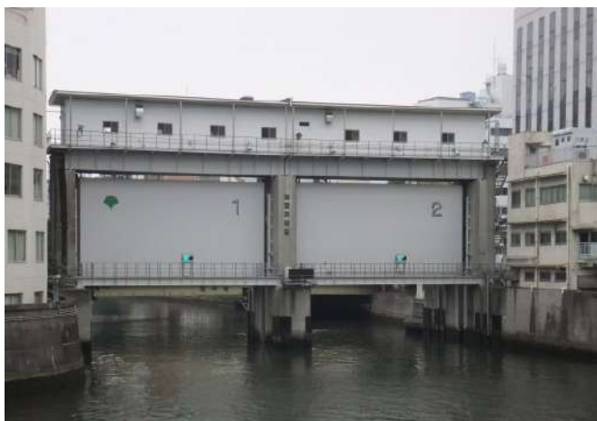
日本橋水門(東京都建設局HPより)
