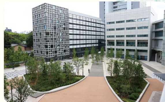
キャンパス中央広場を中心とした工事区域全景
