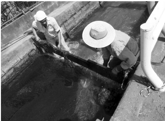
写真：堀浚いの作業の様子（2010年5月著者撮影）
