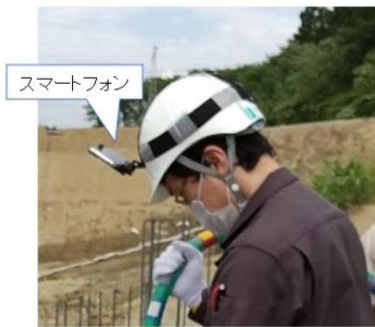
図-1 ウェアラブルカメラの設置状況
