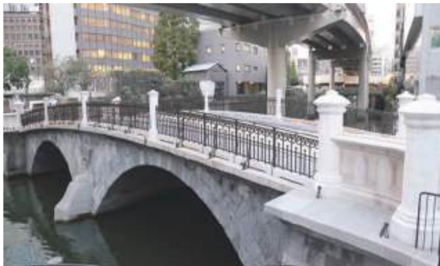
東日本大震災で大きな被害を受け、長い間、修復工事を行っていた常磐橋が本来の姿を取り戻しました。八角形の大理石の親柱と、唐草意匠の手すり柵。そして路面には当時いち早く取り入れられた「歩車分離」（人は端、馬車と人力車は中央）が再現されている。
