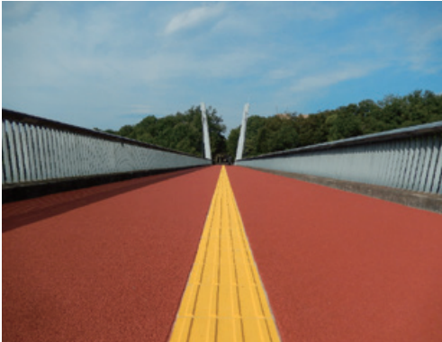
アイリード(点字マット)も設置し、安全に通行できます
