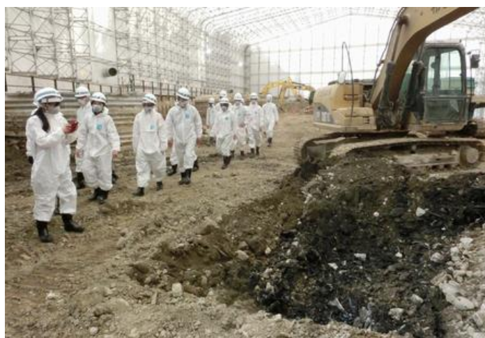
源十郎案件 防護服とマスクを着用して 1,4-ジオキサンの臭気が立ち込める作業場内を見学しました。
