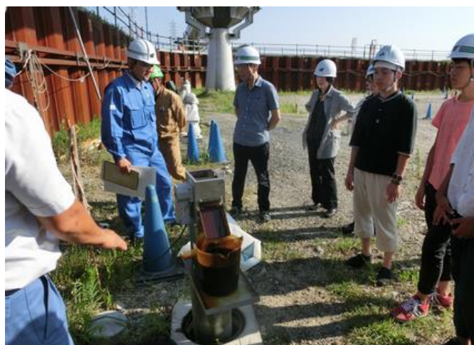
五反田案件 地下に浸透した PCB をベルトで汲み上げて回収しているところです。周囲は鋼矢板に囲まれています。
