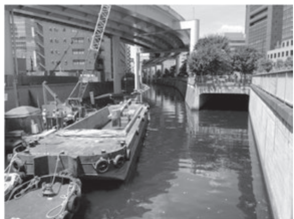
浚渫工事の下流、土運船で汚泥を運ぶ
