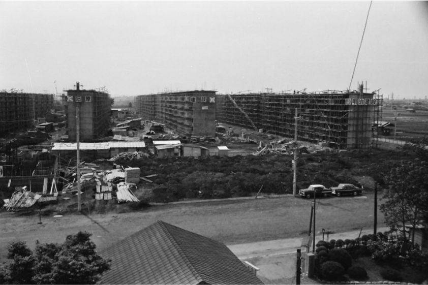
図10 建設中の富士見台団地
