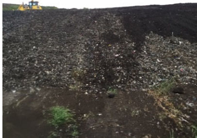
東京湾防波堤外側埋立地の様子
