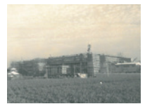
建設中の小金井校舎
