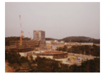
建設中の多摩校舎
