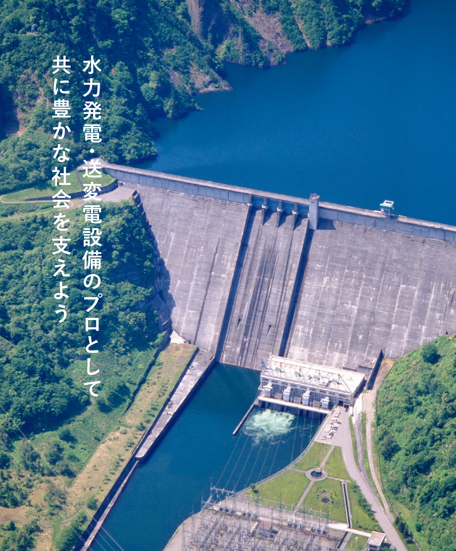
写真：J-POWER 田子倉発電所(福島県)
