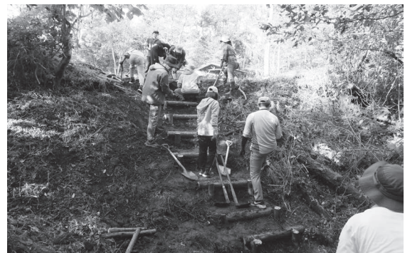
木の階段が完成！
