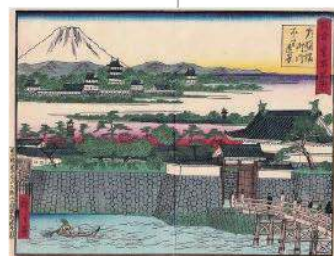
常盤橋初架橋
