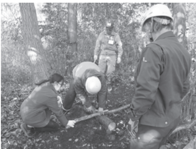
段差となる杭を作ります
