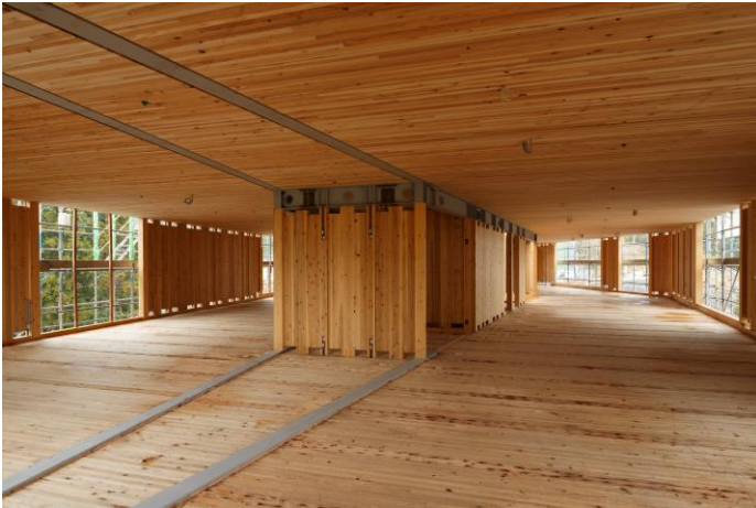
施工写真 (内観)
