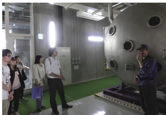
▲金町浄水場の高度処理施設：オゾンによって不純物が分解され、より美味しい水が作られます。
