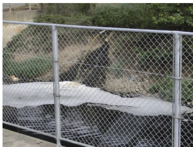
▲最終処分場に降った雨水は焼却灰から有機物などを溶かし出すので真黒になります。地下や周辺に漏れ出ないように集められ、きれいになるまで処理してから海に放流されます。
