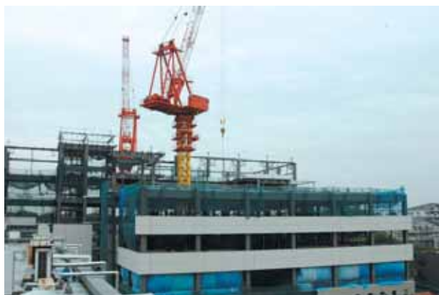
▲建築工事が進む東館（仮称）
