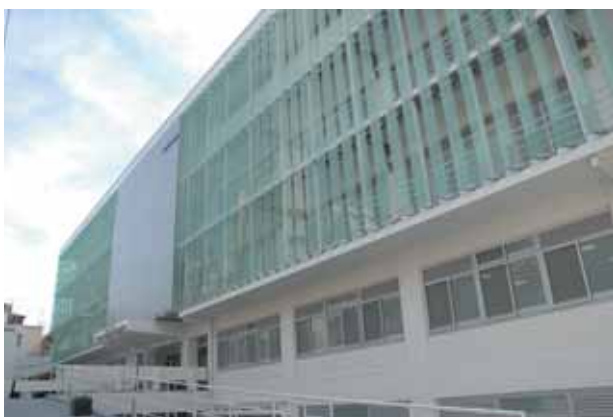
▲現代的な外観の市ヶ谷田町校舎
