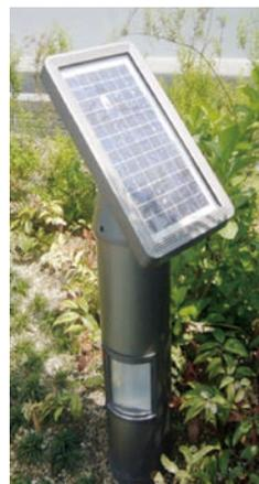
外濠校舎6階及び7階の屋上庭園には、太陽光発電パネル付ガーデンライトを設置し、照明設備に自然エネルギーを利用しています（P13、15）。
