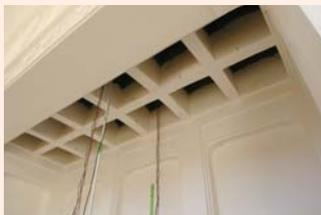
採風塔の下は多数に分割されたダクトになっており、風向によって、風が流入するブロックと流出するブロックとがある。
